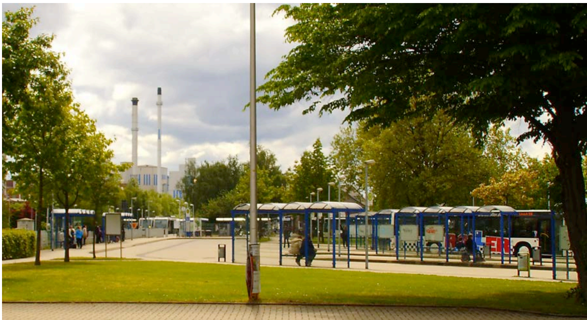
Zentraler Omnibus Bahnhof (ZOB) am Jülicher Rurtalbahn
